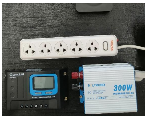
Instalación de equipos de energía solar
