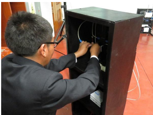
Instalación de componentes en gabinetes
